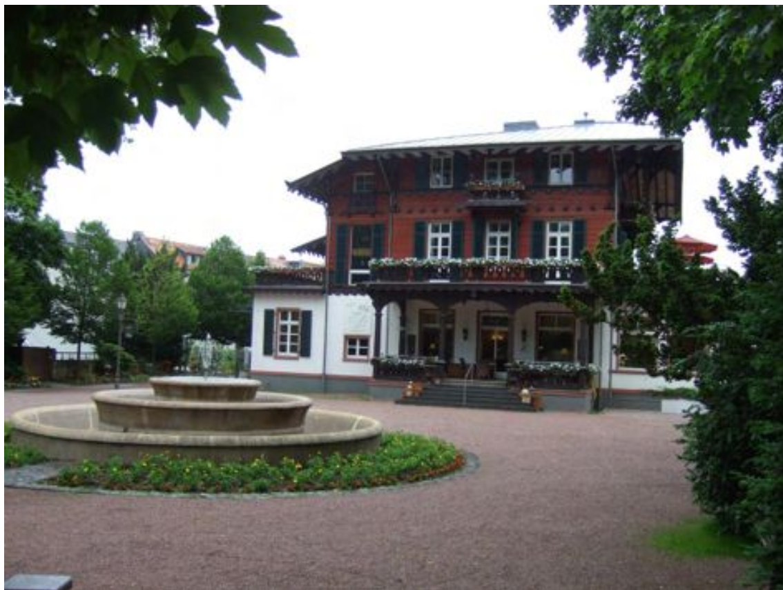
Abb. 109: Blick auf die westliche Fassade des Kurhauses (Quelle: Büro Löw 2010)
