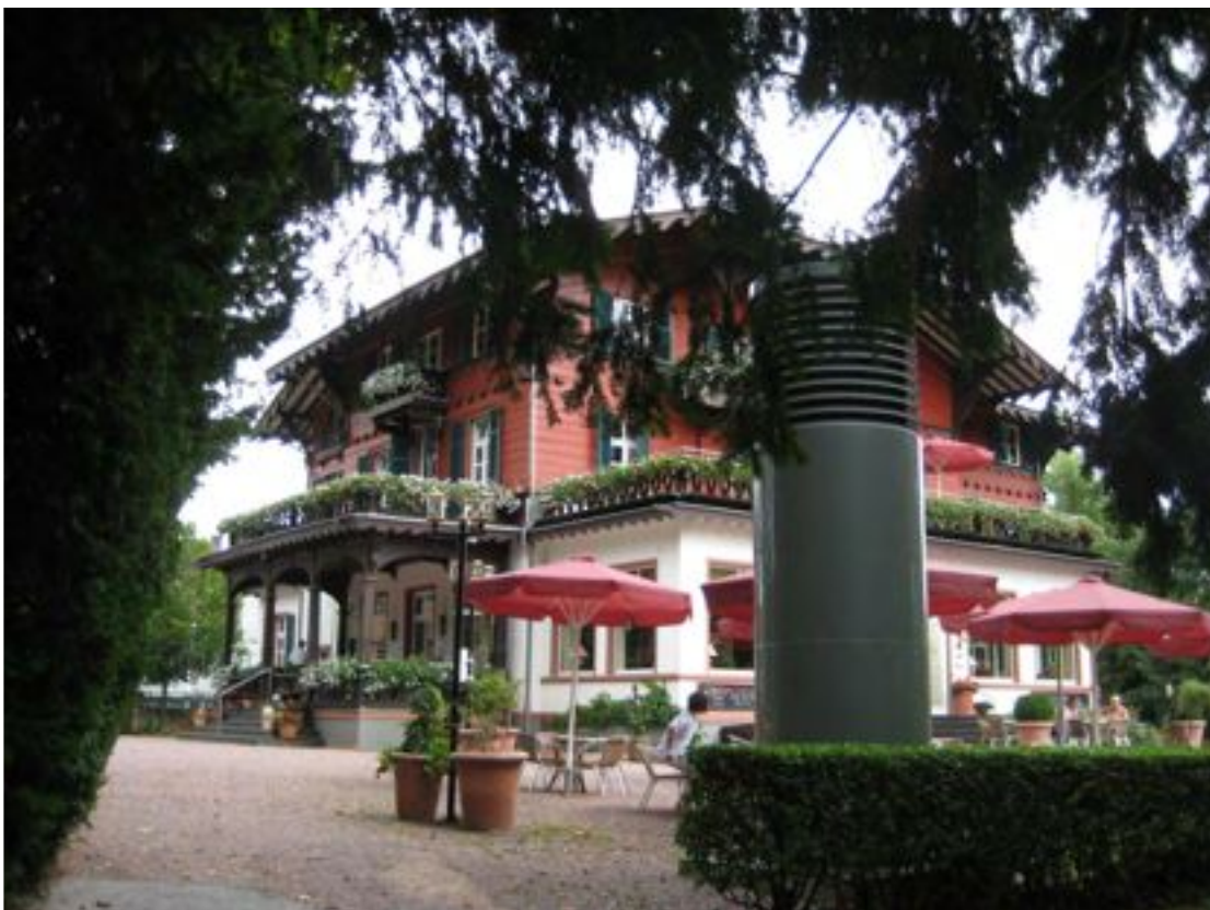
Abb. 116: Blick auf das Kurhaus von Südwest (Quelle: Büro Löw 2010)
