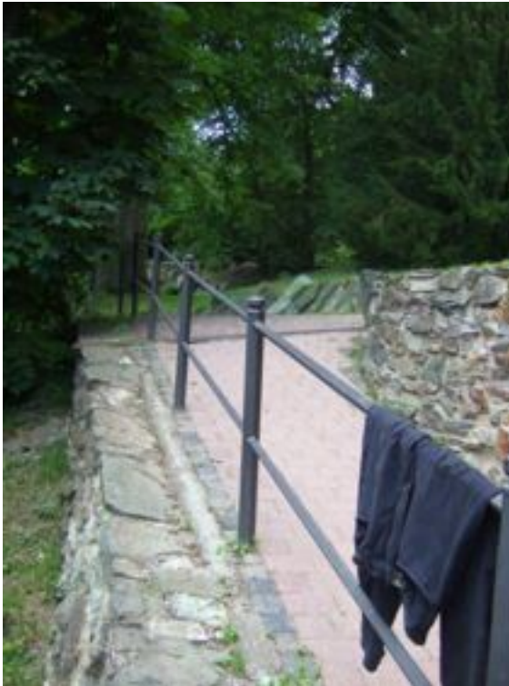
Abb. 96: Parkaus- bzw. -eingang zum Seilerbahnweg (Quelle: Büro Löw 2010)
