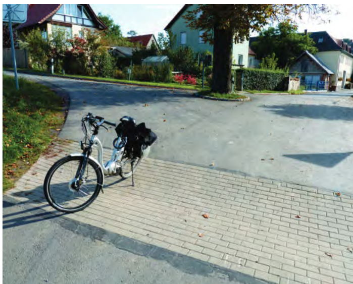
Großzügige Mulde als Entwässerungsrinne
