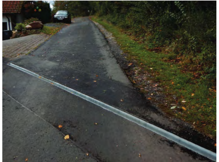
Entwässerungsrinne auf Wirtschaftsweg
