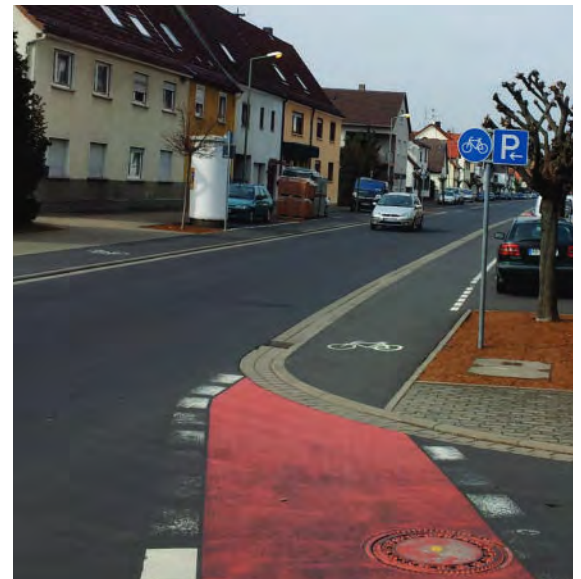
Bordsteinabsenkung Fahrbahn - Radweg, Frankfurt am Main
