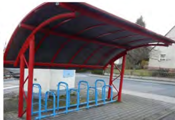
Abbildung 8: Überdachte Abstellanlage, Schneidhain
