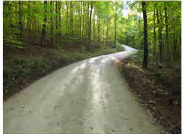
Abbildung: Beispiel gut befahrbare wassergebundene Decke
