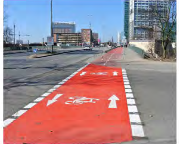
Rot eingefärbter Zweirichtungsradweg
