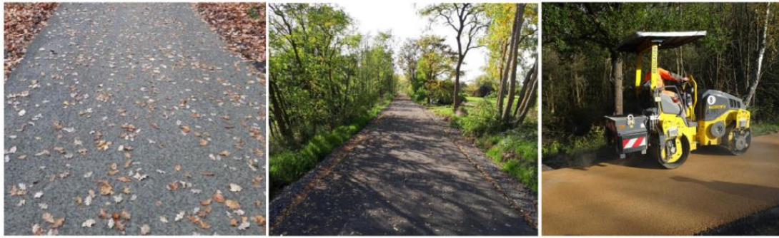
Abbildung 5: Asphaltähnliche Deckschichten aus Gemisch von Basaltstein und Spezialsanden / heller Split-Mastix-Asphalt
